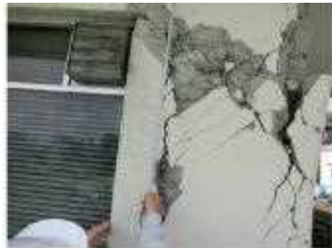
外来臨床研究棟 柱ひびわれ
